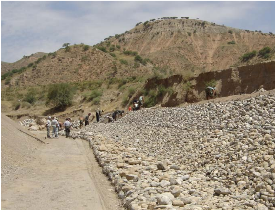
Abb. 6 Uferbefestigung am Aylampa Say – TP 2
