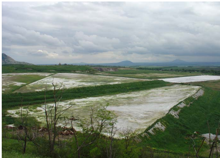
Abbildung 2 Schlammteich des Aufbereitungsbetriebes "Almaz" am Standort Lermontov, mit Phosphogips-Abdeckung aus der Düngemittelherstellung
