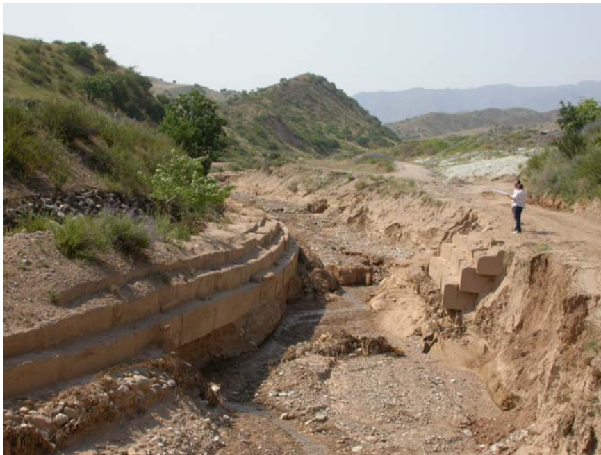
Abbildung 5 Erosion von Tailingsmaterial, welches in unmittelbarer Nähe zum Flussbett (bzw. darin) abgelagert wurde
